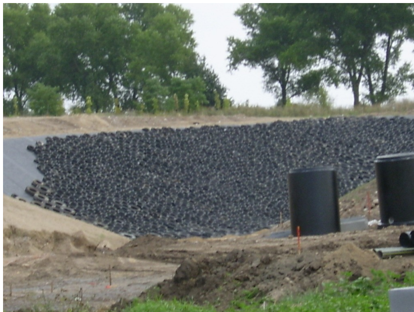
Rys. 5.1 Budowa nowej kwatery na składowisku w Starym Brześciu
